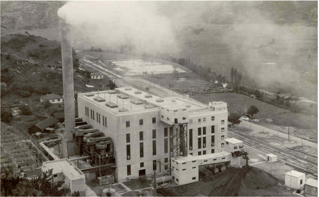
Fotoğraf 70. Çatalağzı Termik Santrali
