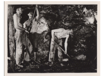
Fotoğraf 28. Maden ocağında havalı matkapla kömür dekupe eden maden işçileri (SALT Araştırma)
