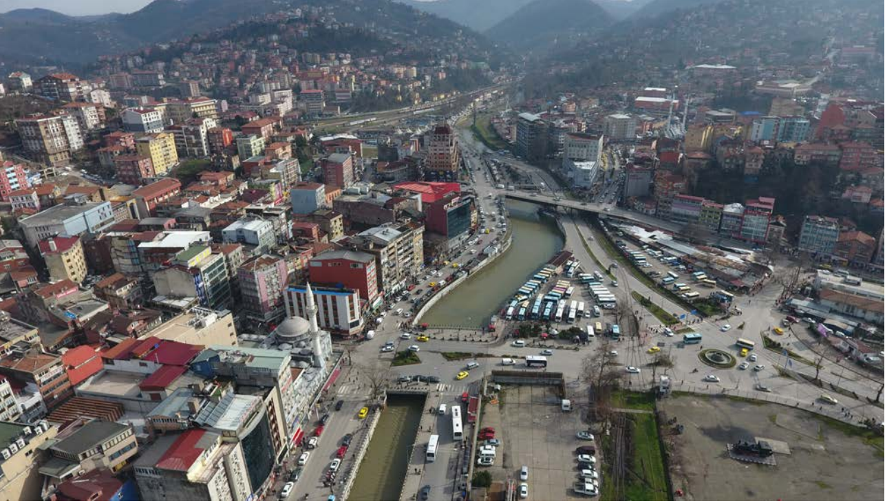
Fotoğraf 64. Fevkani Köprüsü
