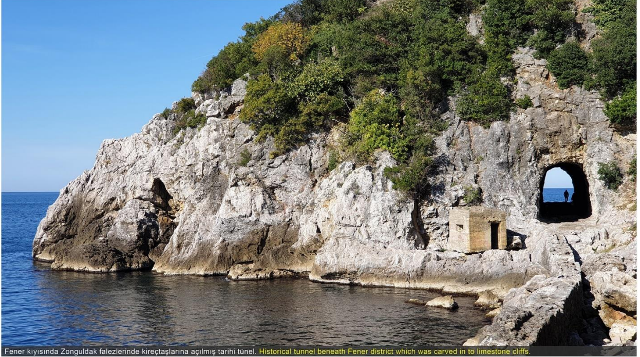
Fener kıyısında Zonguldak falezlerinde kireçtaşlarına açılmış tarihi tünel. Historical tunnel beneath Fener district which was carved in to limestone cliffs.
