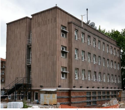
Foto 121:Restore edilmekte olan İller bankası binası.
