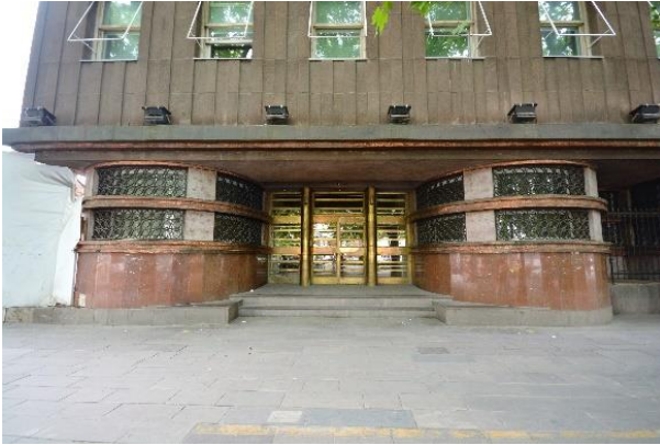
Foto 122:Restore edilmekte olan İller bankası binası.
