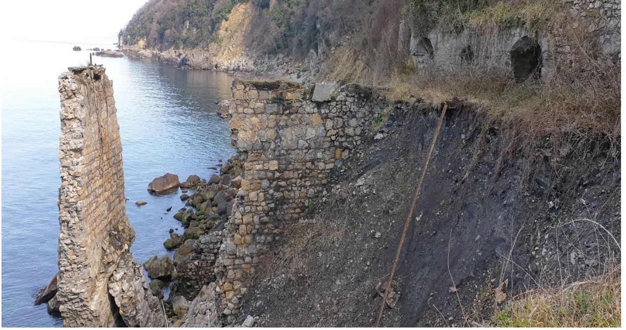
Foto 50:Kandilli kömür ocağı ve yapıları kıyı aşındırması sonucu kullanılamayacak hale gelmiştir.
