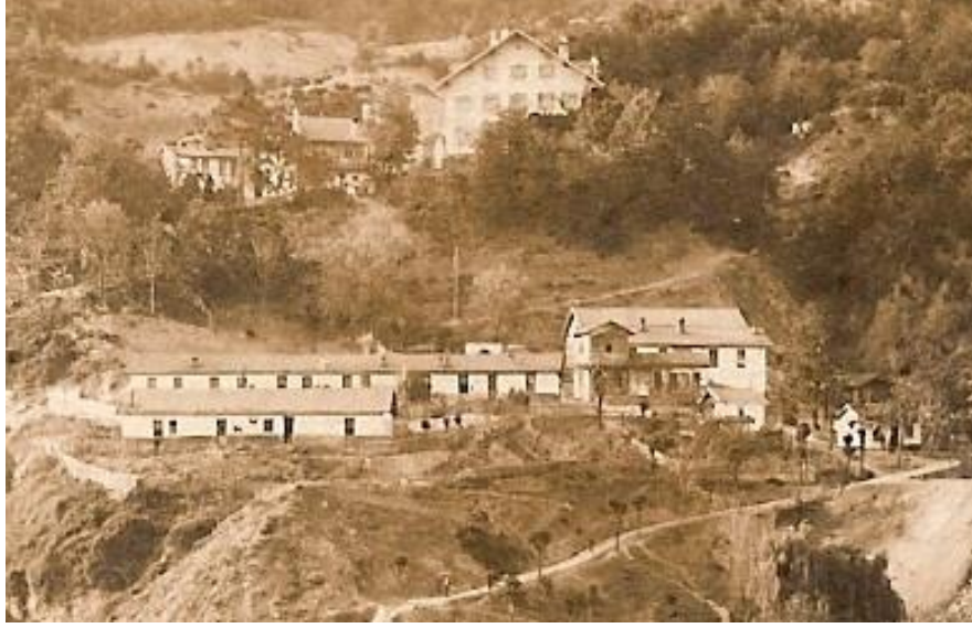
Foto 62:Rombaki köşkünden, aşağıdaki demiryoluna inen bir patika yol vardı. Bu yoldan Mühendisler, Derebaca 'ya ve demiryoluna atla inerlerdi.(1934 öncesi).
