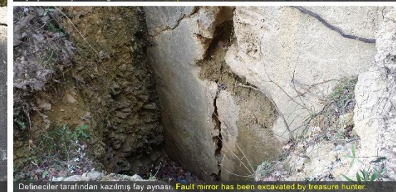
Defineciler tarafından kazılmış fay aynası. Fault mirror has been excavated by treasure hunter.
