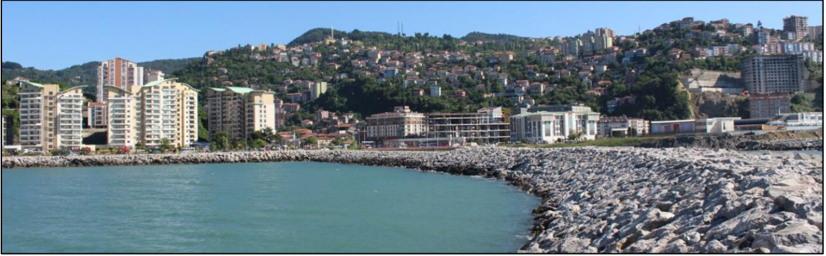
Foto 41:Zonguldak Karadeniz kıyılarındaki antropojenik kökenli, Dar ve yüksek, yapay kıyı türlerinden biri de kıyı mühendislik yapılarıdır.
