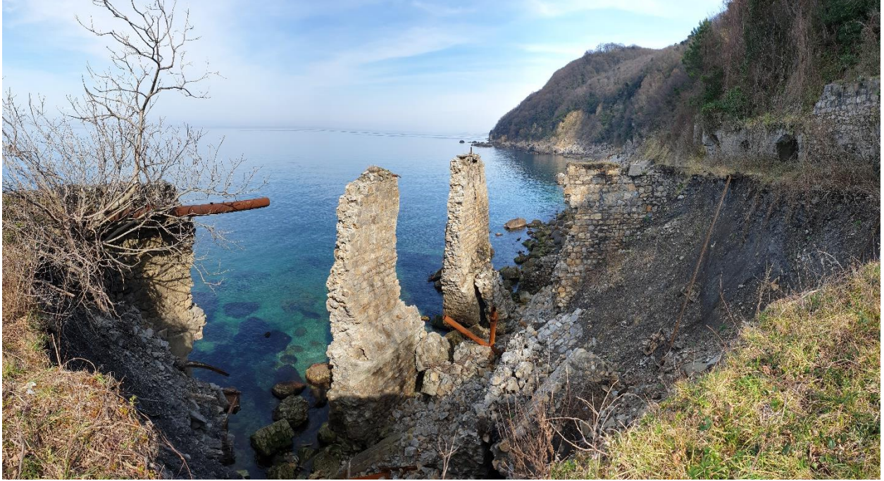
Foto 94:Kandilli işletmesine dair endüstriyel miras yapıları kıyı aşındırması sonucu çökmektedir
