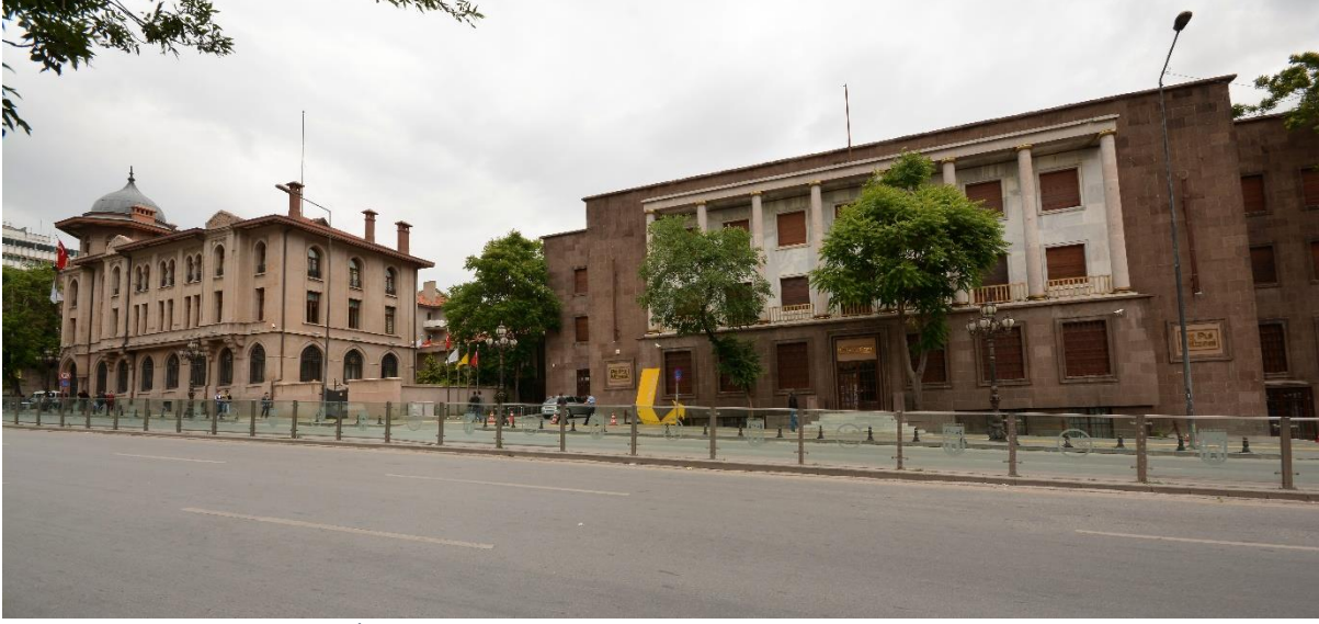
Foto 123:Restore edilmekte olan İller bankası binası.
