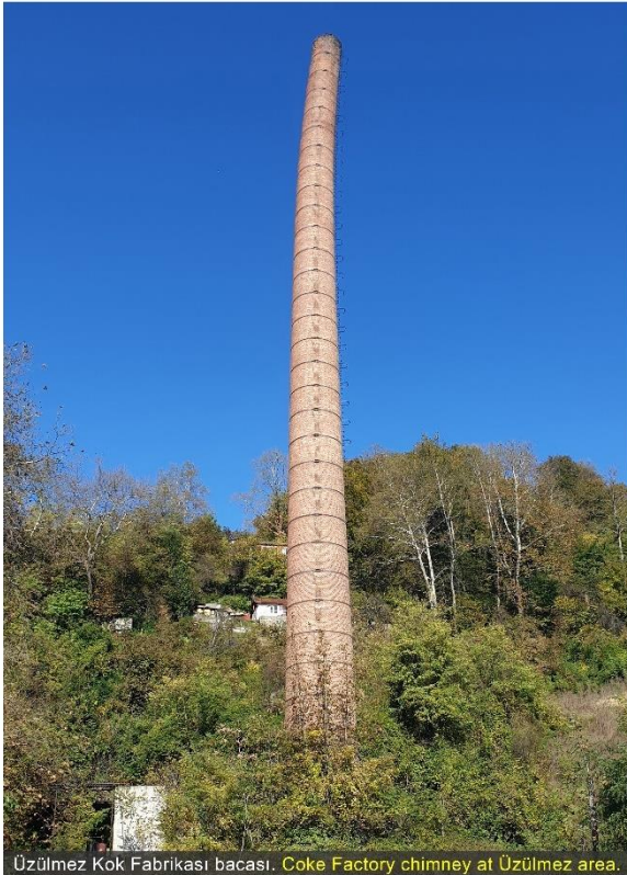
Üzülmez Kok Fabrikası bacası. Coke Factory chimney at Üzülmez area.
