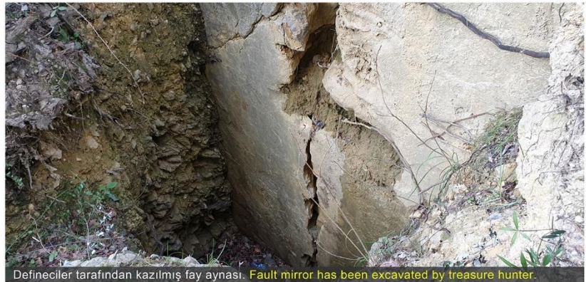
Defineciler tarafından kazılmış fay aynası. Fault mirror has been excavated by treasure hunter.
